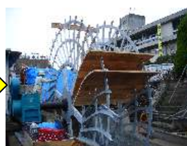
ブレード取付
